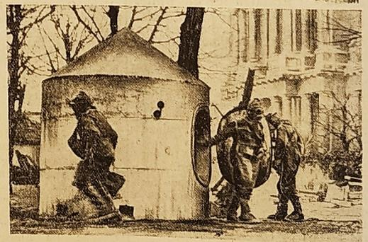
Der Pariser Luftschutz hat jetzt diese transportablen gas-sicheren Unterstände eingeführt, die in erster Linie zur Aufnahme von freiwilligen Rettungskolonnen dienen.
